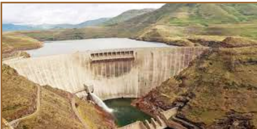
Site du Barrage de Kandadji sur le Fleuve Niger
